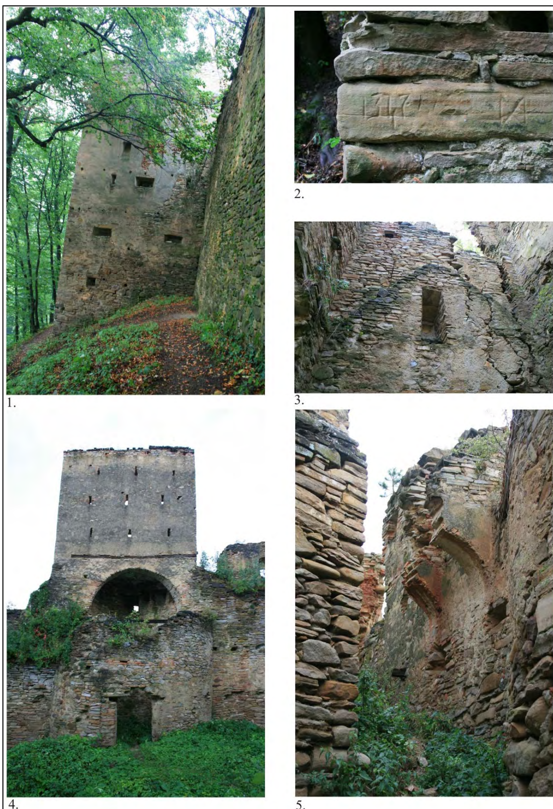
Pl. 4.1. Turnul voievodal, vedere din exterior. 2. Piatra cu inscripție încastată în zidăria turnului voievodal. 3. Detaliu de parament din interiorul turnului preotului. 4. Turnul școlii văzut din interiorul incintei. 5. Detaliu de parament, ruina laturii nordice a zwingerului.
